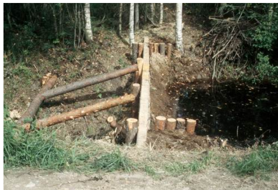
25 pav. Medžių ir durpių užtvara patvenktas pelkę sausinantis kanalas.
